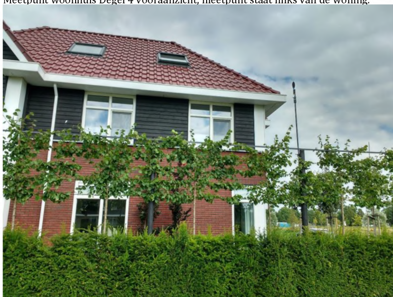
Meetpunt woonhuis Degel 4 zijaanzicht, meetpunt staat in verlengde van de voorgevel.
