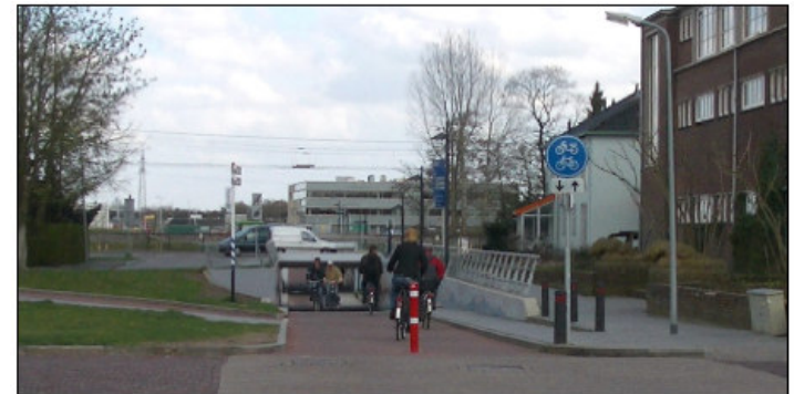
Figuur 4.6: Fietstunnel van Oosterboer naar Het Vledder
