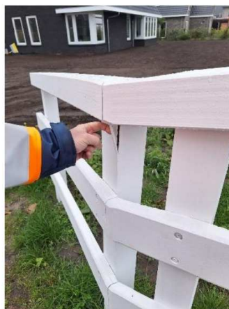
splintervorming
