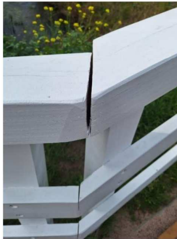
aansluiting leuningwerk/ verstek
