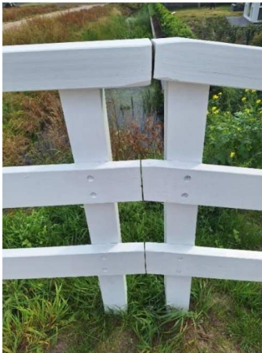
Hoogte/dikte afwijkingen / aansluiting leuningdelen niet in één lijn
