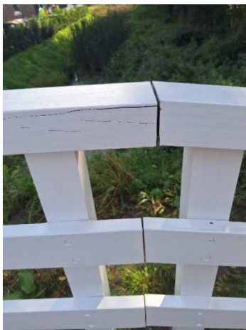
Langsscheuren/ruimte 5mm mechanische beschadiging
