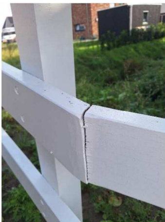
Mechanische beschadiging
