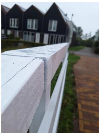
Langsscheuren/ leuning niet in lijn
