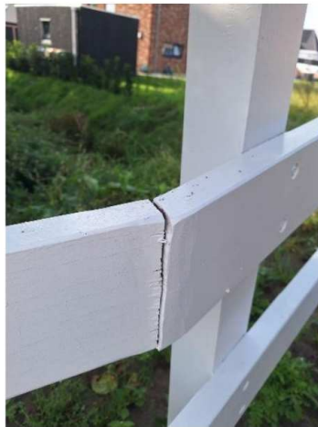
Langsscheuren/ruimte 5mm mechanische beschadiging
