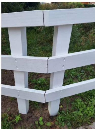
Hoogte/dikte afwijkingen / aansluiting leuningdelen niet in één lijn
