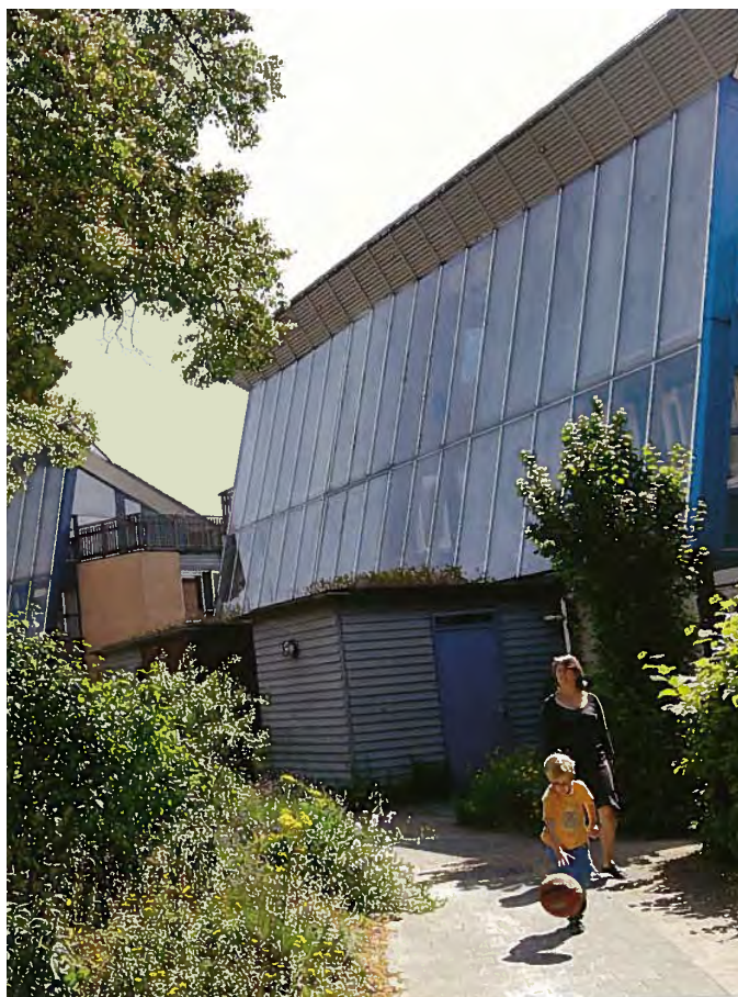
glas op het zuiden (zonne-energie)
