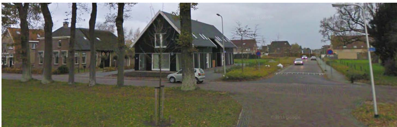
Dannige Erve I - nieuwbouw met het dorpslint als referentie
