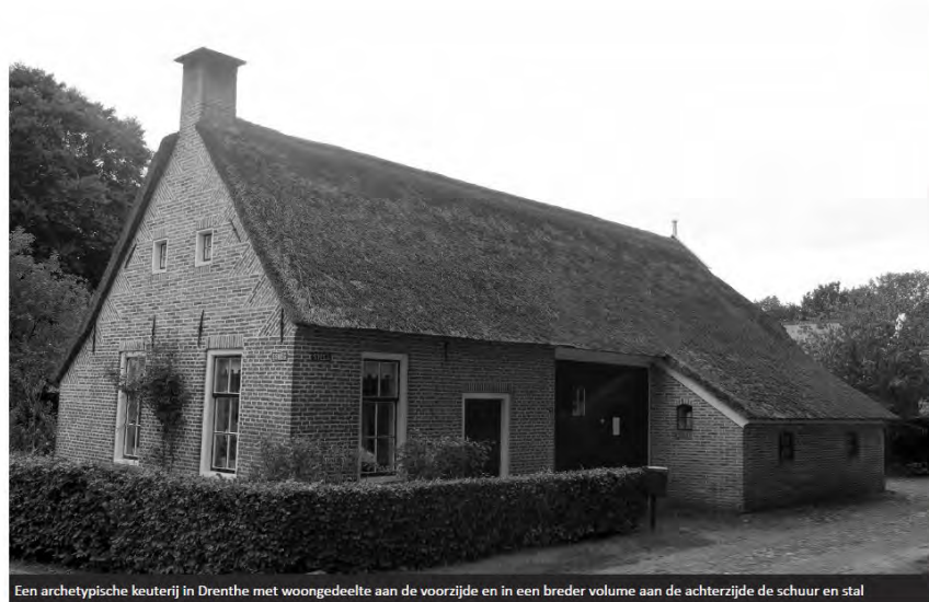
Een archetypische keuterij in Drenthe met woongedeelte aan de voorzijde en in een breder volume aan de achterzijde de schuur en stal
